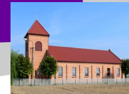
KOŚCIÓŁ FILIALNY pw. Najświętszego Serca Pana Jezusa w Warszewicach
